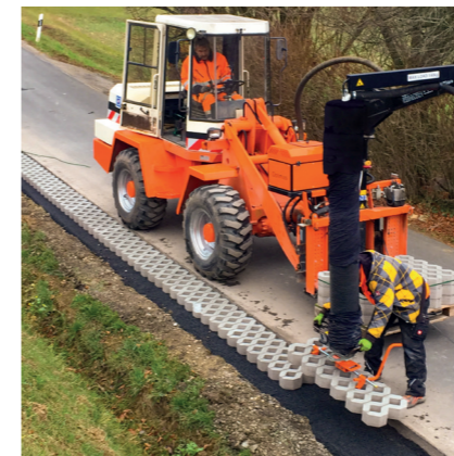
Verlegung Rasengitter-Steine mit Optimas-Vacu-Lift
