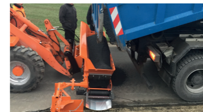
Die Schaufel wird direkt vom LKW befüllt.
