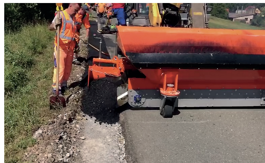
1,4 m³ Finliner Asphaltbau
